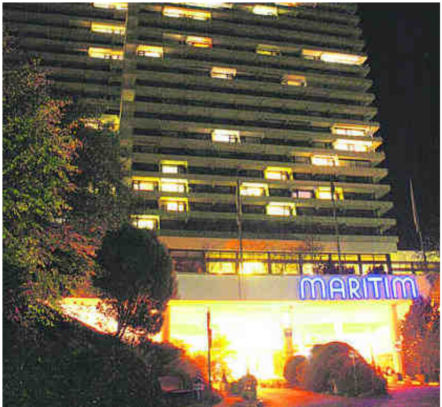
Hochhäuser wie das Maritim Club Hotel in Timmendorfer Strand stellen die Feuerwehren im Fall der Fälle vor eine schwierige Aufgabe. Foto: Meier
